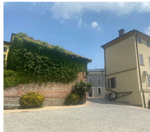
CASTAGNOLE DELLE LANZE (AT) REALIZZAZIONE NUOVO BELVEDERE
