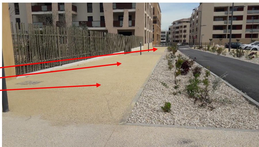
Fig. 2 : Zones de réalisation des essais de drainabilité ( rue De Fresse de Monval ).
